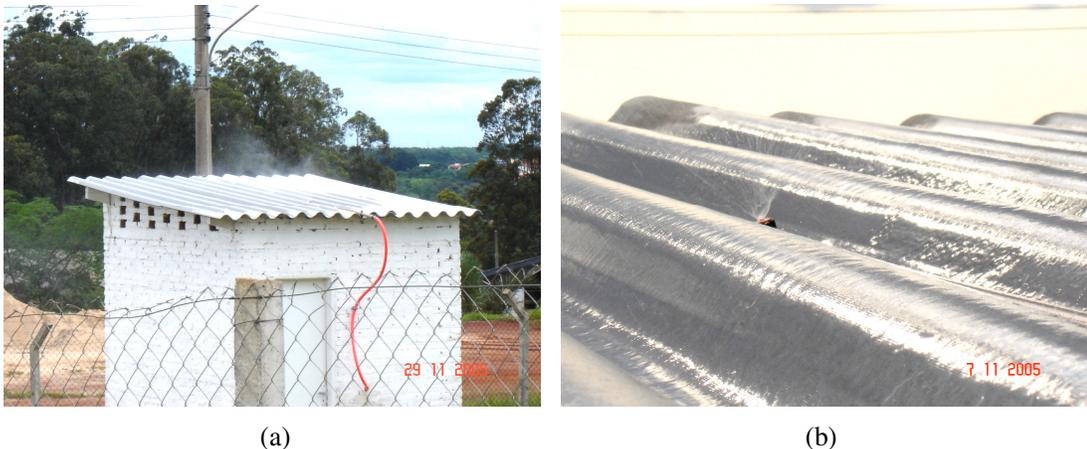
Figura 6 – Resfriamento evaporativo: (a) Aspersão na cobertura; (b) Detalhe do microaspersor.
